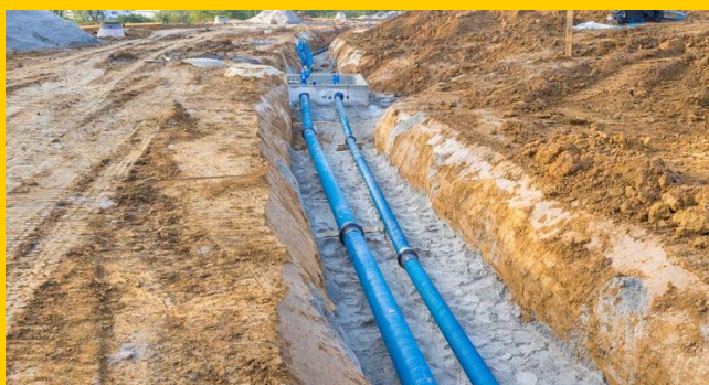
Aanleg leidingen foto: bouw en installatie hub
